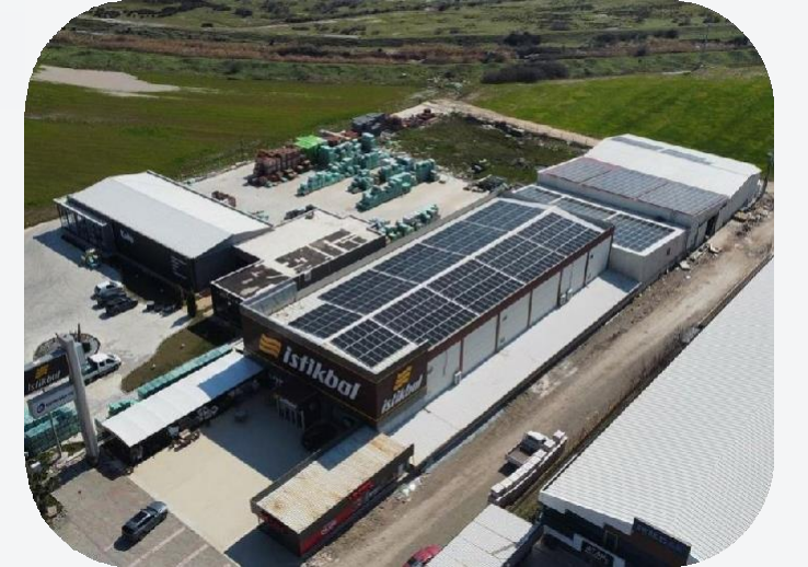
4) Tamamlanmış santralin drone görüntüsü
